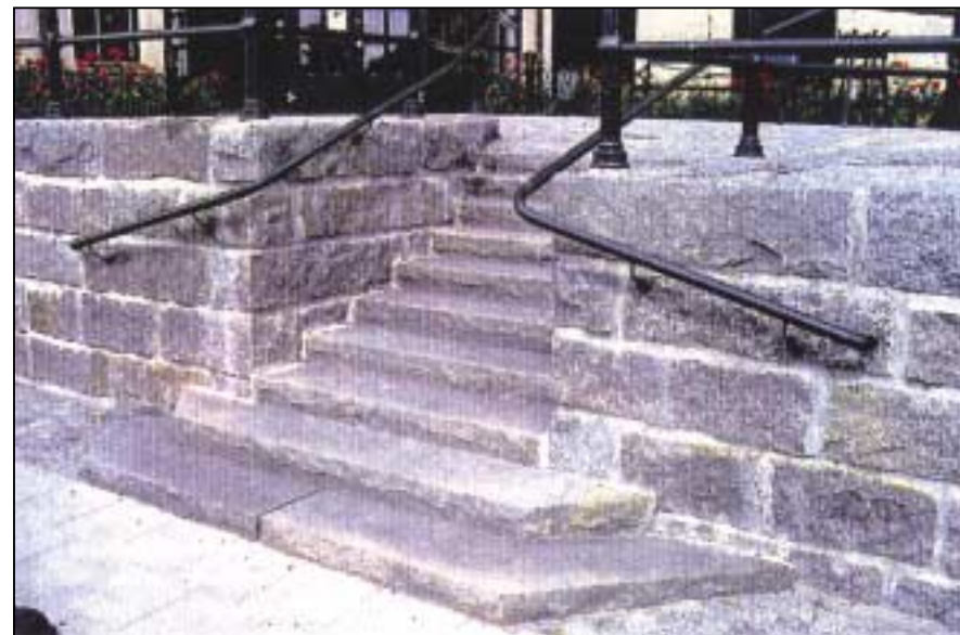
Eksempel på natursteinsmur
